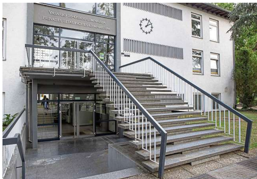
Die Fördermittel sollen unter anderem zur Sanierung des Eingangsbereichs am Litauischen Gymnasium in Hüttenfeld verwendet werden. Foto: Thorsten Gutschalk
